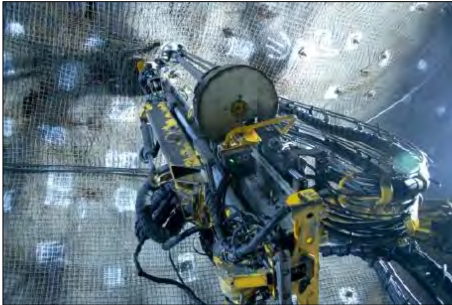
Imagen 3.1 Equipo Boltec en instalación de pernos fibercret IVS
